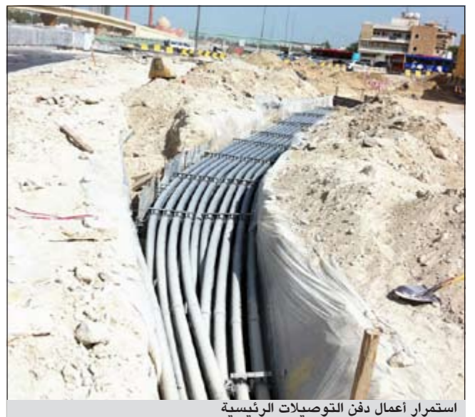
استمرار أعمال دفن التوصيلات الرئيسية
