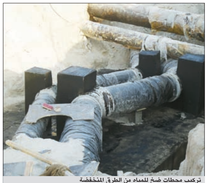
تركيب محطات ضخ للمياه من الطرق المنخفضة
