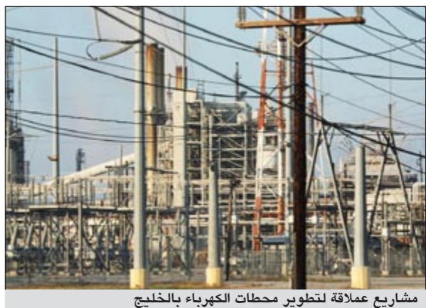
مشاريع عملاقة لتطوير محطات الكهرباء بالخليج
