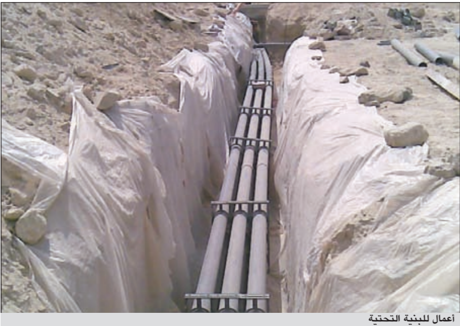
أعمال للبنية التحتية
