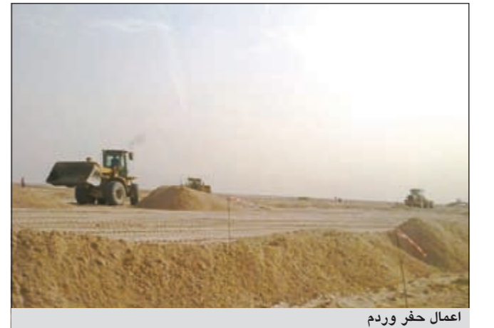
اعمال حفر وردم
