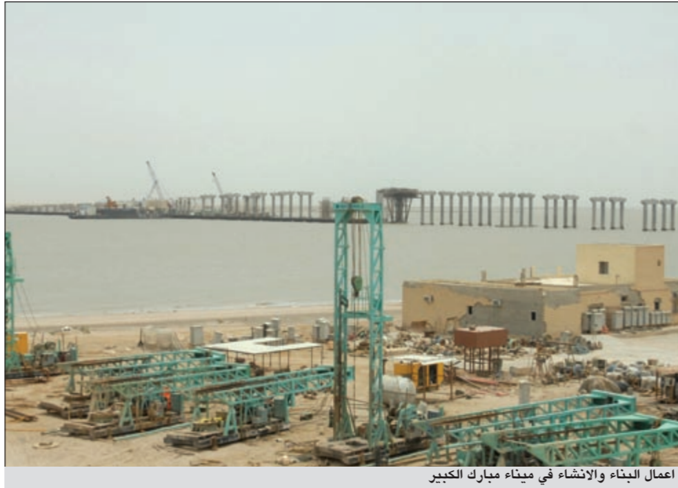
أعمال البناء والإنشاء في ميناء مبارك الكبير
