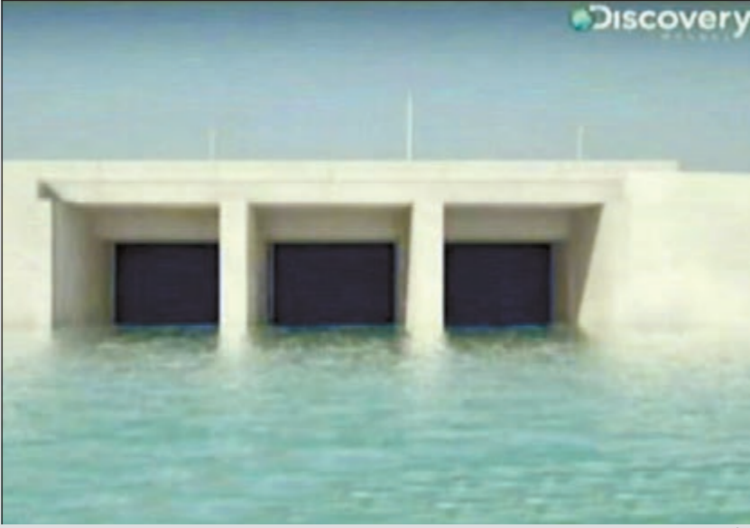
فتح القناة المائية الخاصة بجلب مياه البحر إلى المدينة
