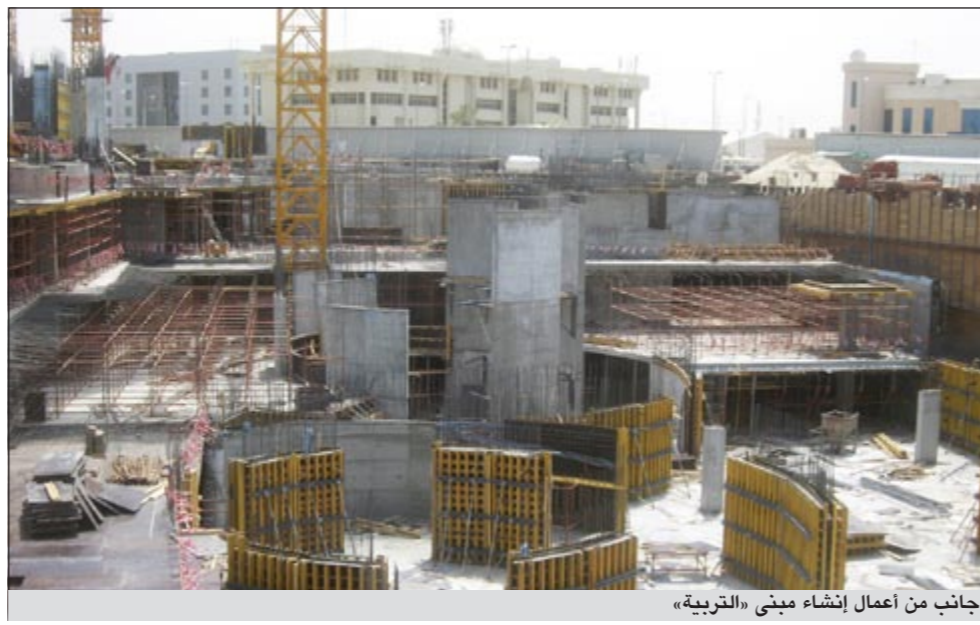
جانب من أعمال إنشاء مبنى «التربية»
