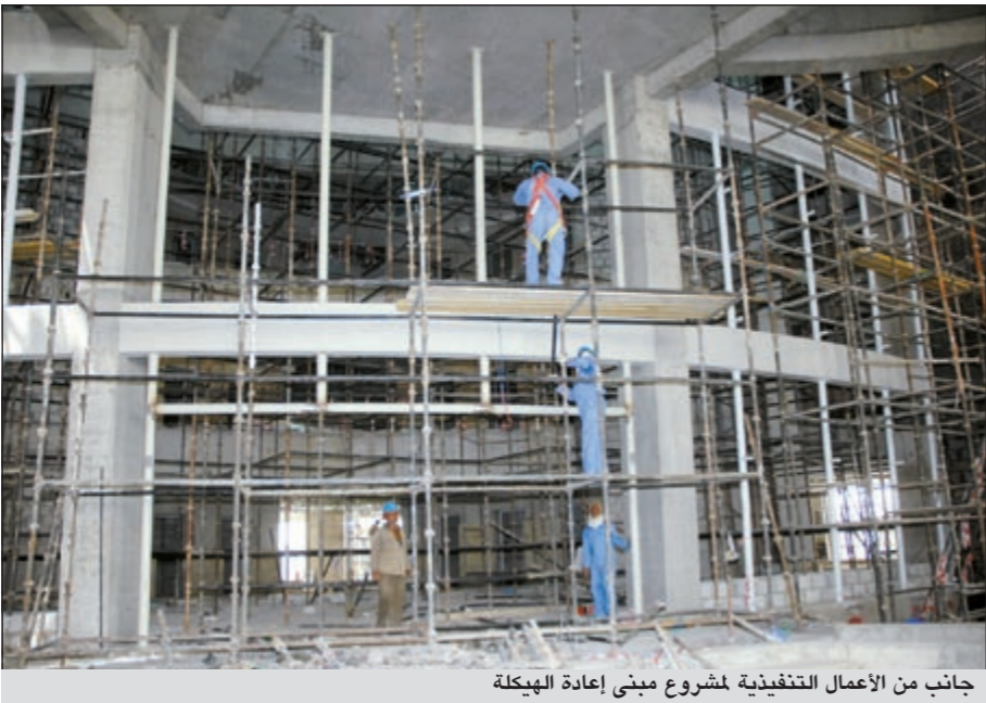
جانب من الأعمال التنفيذية لمشروع مبنى إعادة الهيكلة
