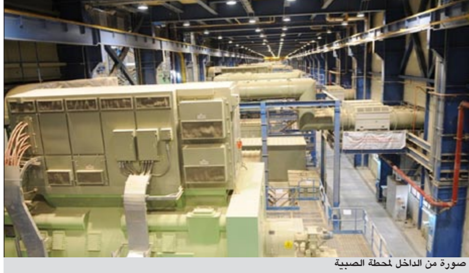
صورة من الداخل لمحطة الصبية
