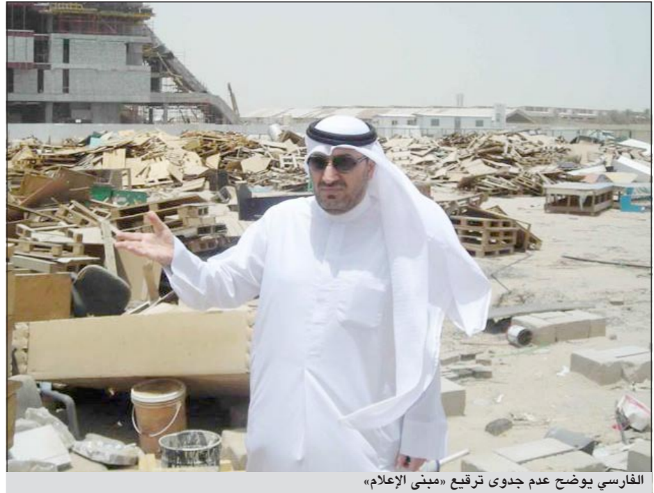
الفارسي يوضح عدم جدوى ترقيع «مبنى الإعلام»
