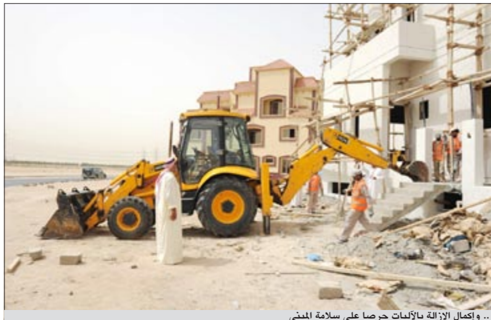
.. وإكمال الإزالة بالآليات حرصاً على سلامة المبنى
