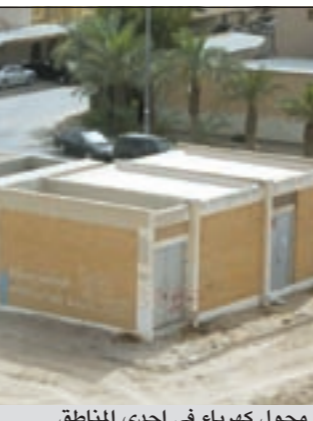
محول كهرباء في إحدى المناطق
