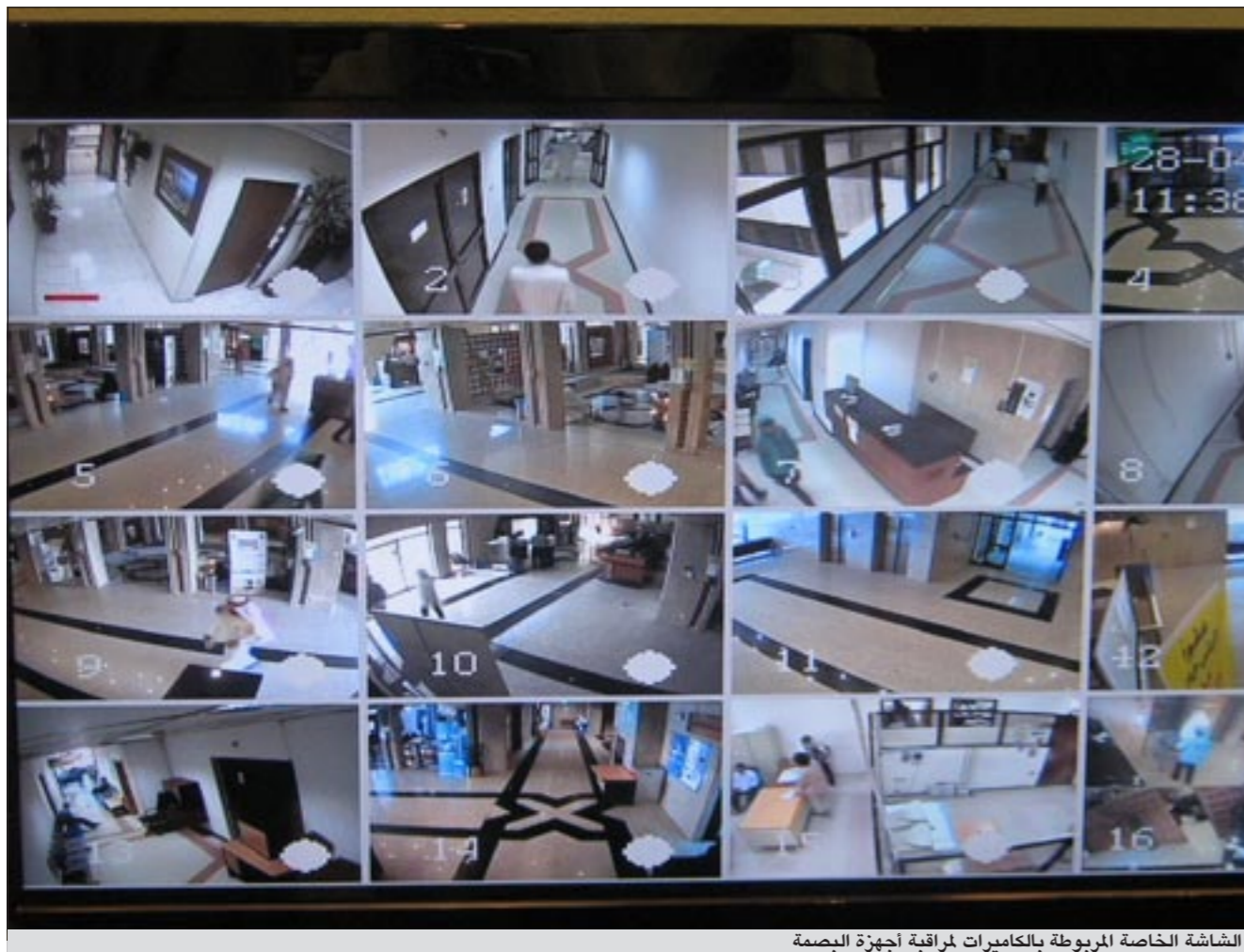
الشاشة الخاصة المربوطة بالكاميرات لمراقبة أجهزة البصمة
