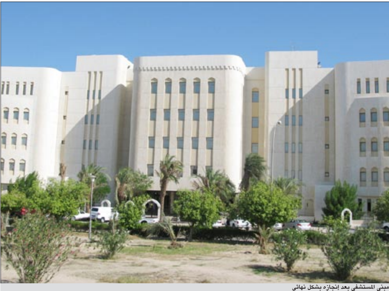
مبنى المستشفى بعد إنجازه بشكل نهائي
