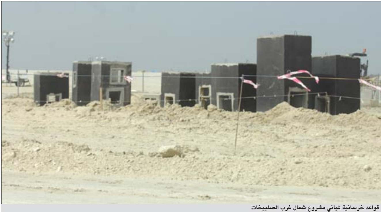
قواعد خرسانية لمباني مشروع شمال غرب الصليبيخات
