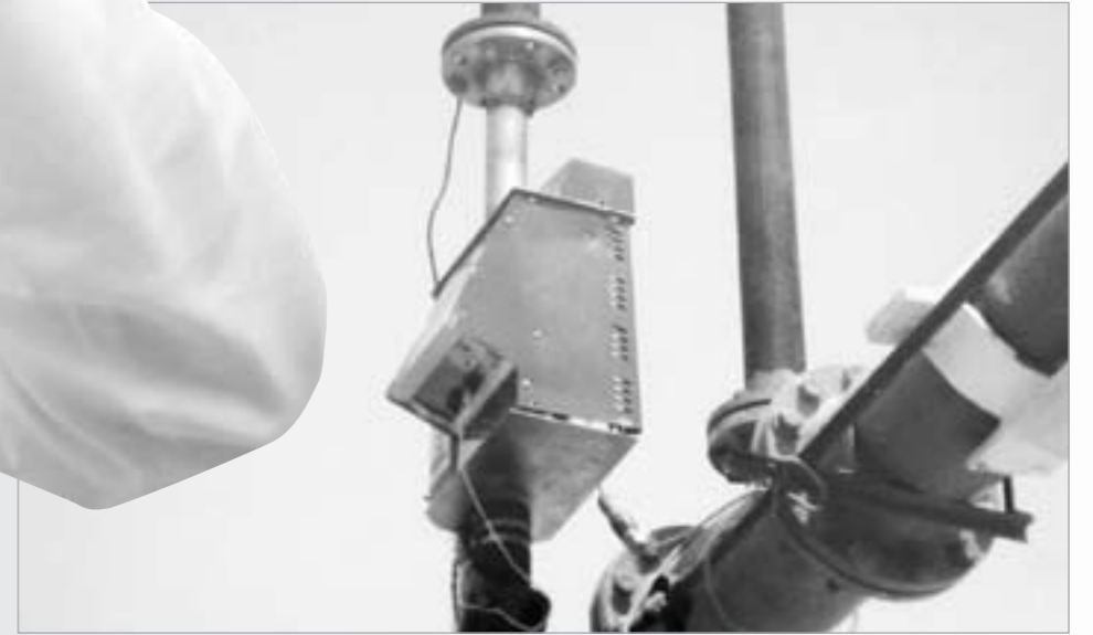
نموذج لعداد الدفع المسبق في محطات تعبئة المياه الموجودة في سلطنة عمان
