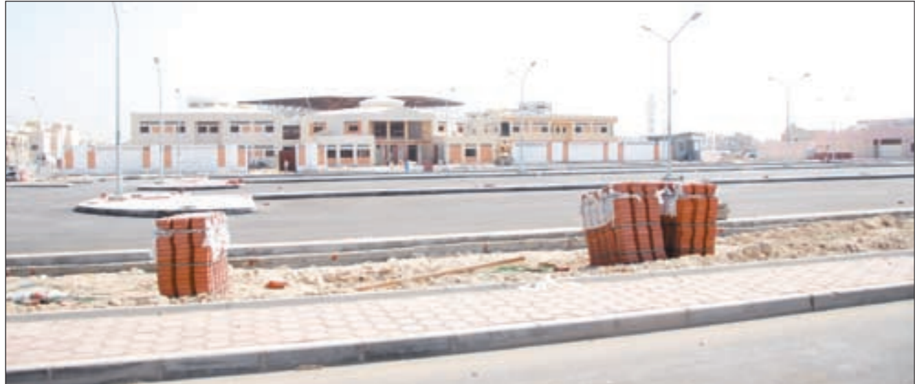
جانب من شوارع المنطقة وتبدو أعمال الرصف والترميم
