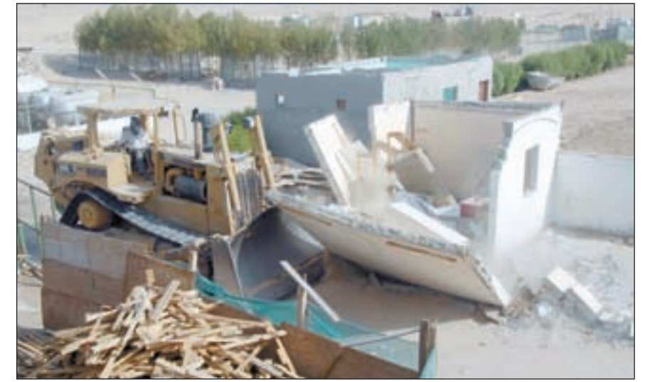
جرافة تزيل غرفة مخالفة
