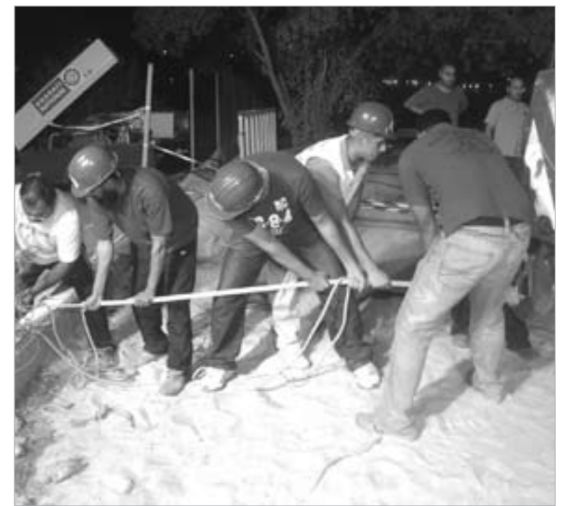
جانبا من عملية تثبيت الحبل الذي سيقوم بإنزال البالون إلى المنهول
