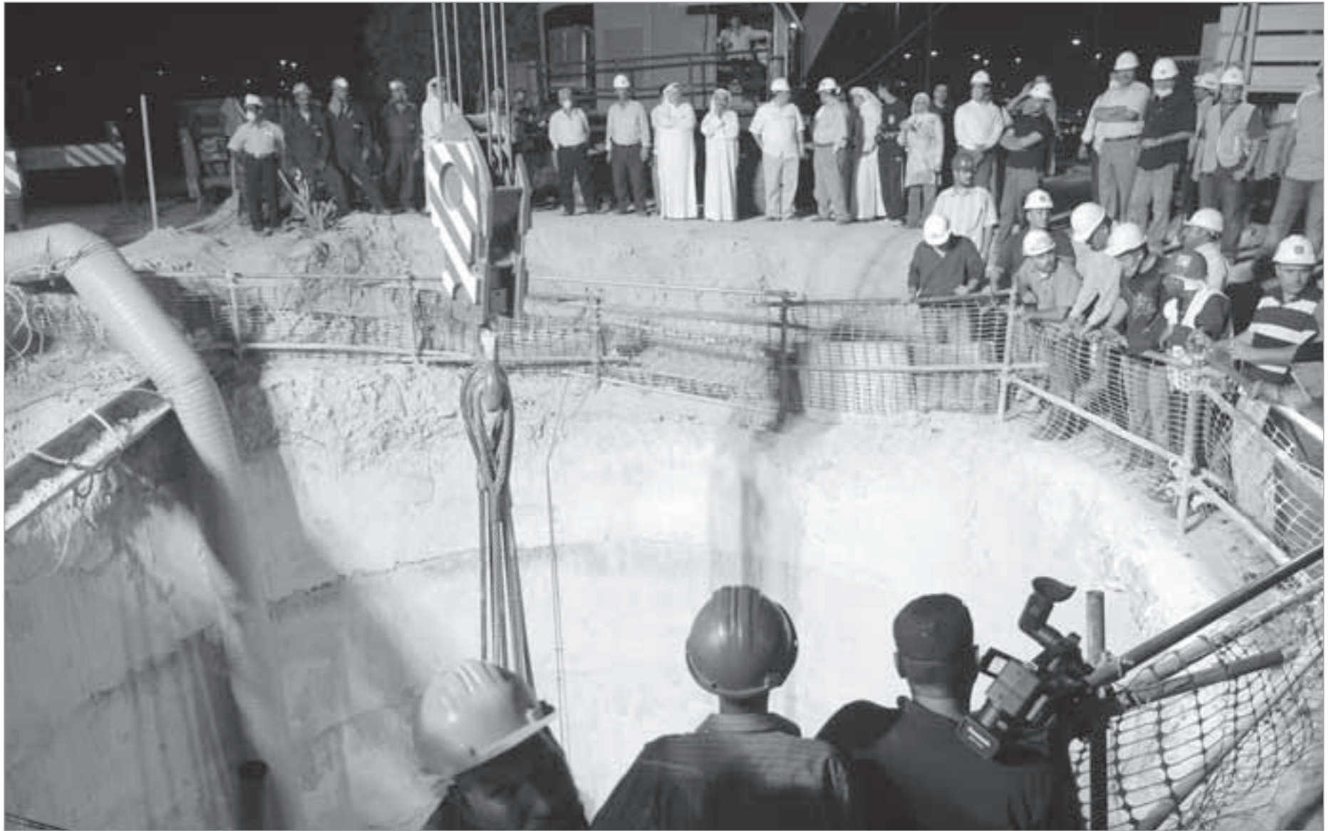
متابعة لعملية إغلاق المنهول رقم 7 لمنع مياه الصرف الصحي من الوصول إلى محطة مشرف
