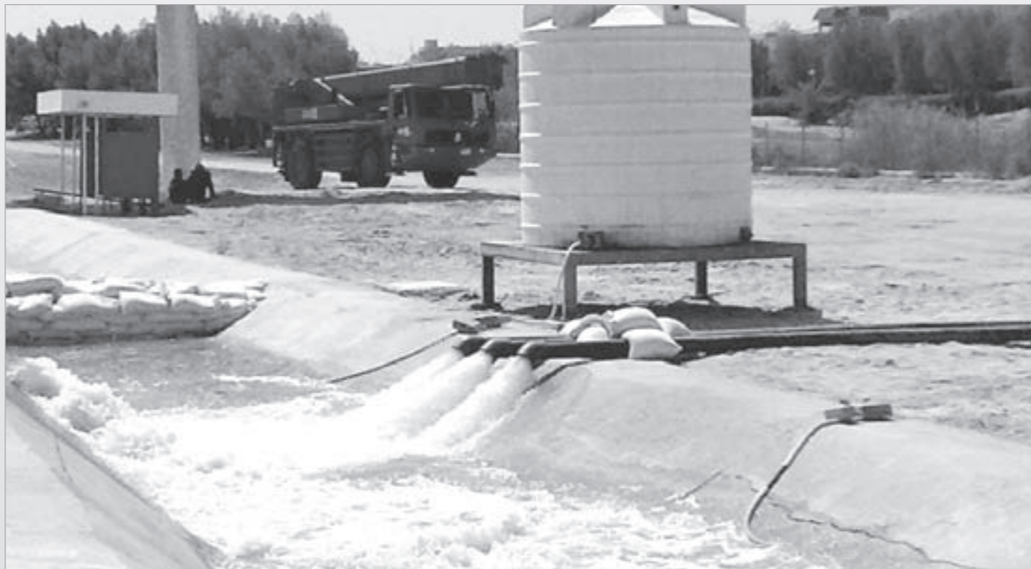
مياه الصرف الصحي يتم إفرانها بمنهول الأمطار
