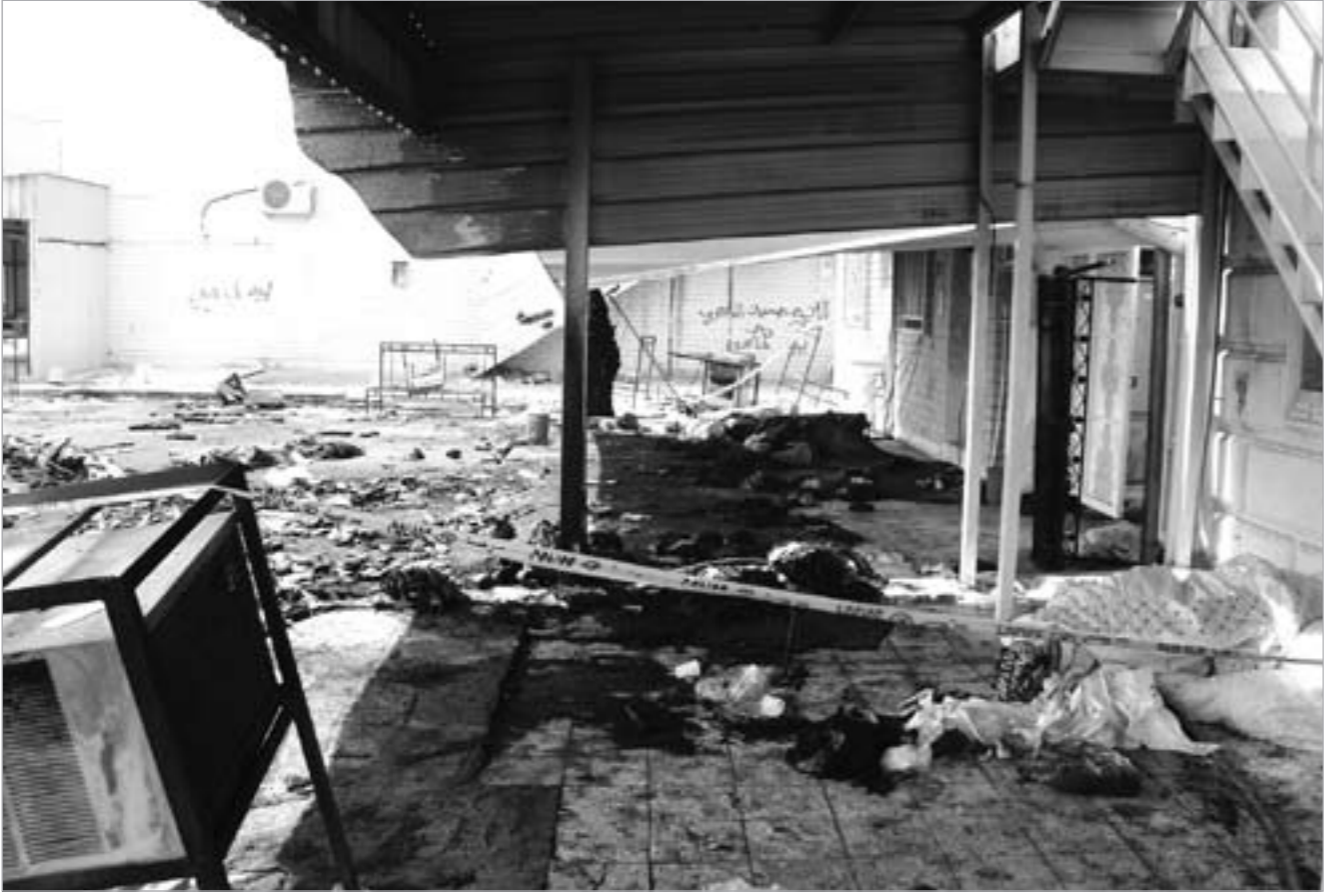
آثار الحريق في موقع الخيمة ويبدو أحد أجهزة التكييف
