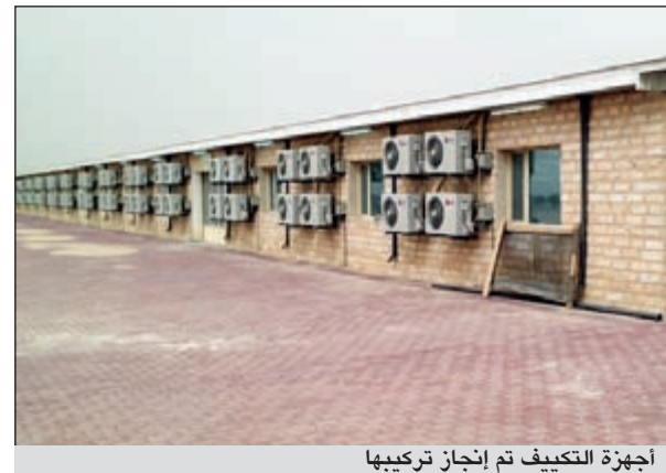
أجهزة التكييف تم إنجاز تركيبها
