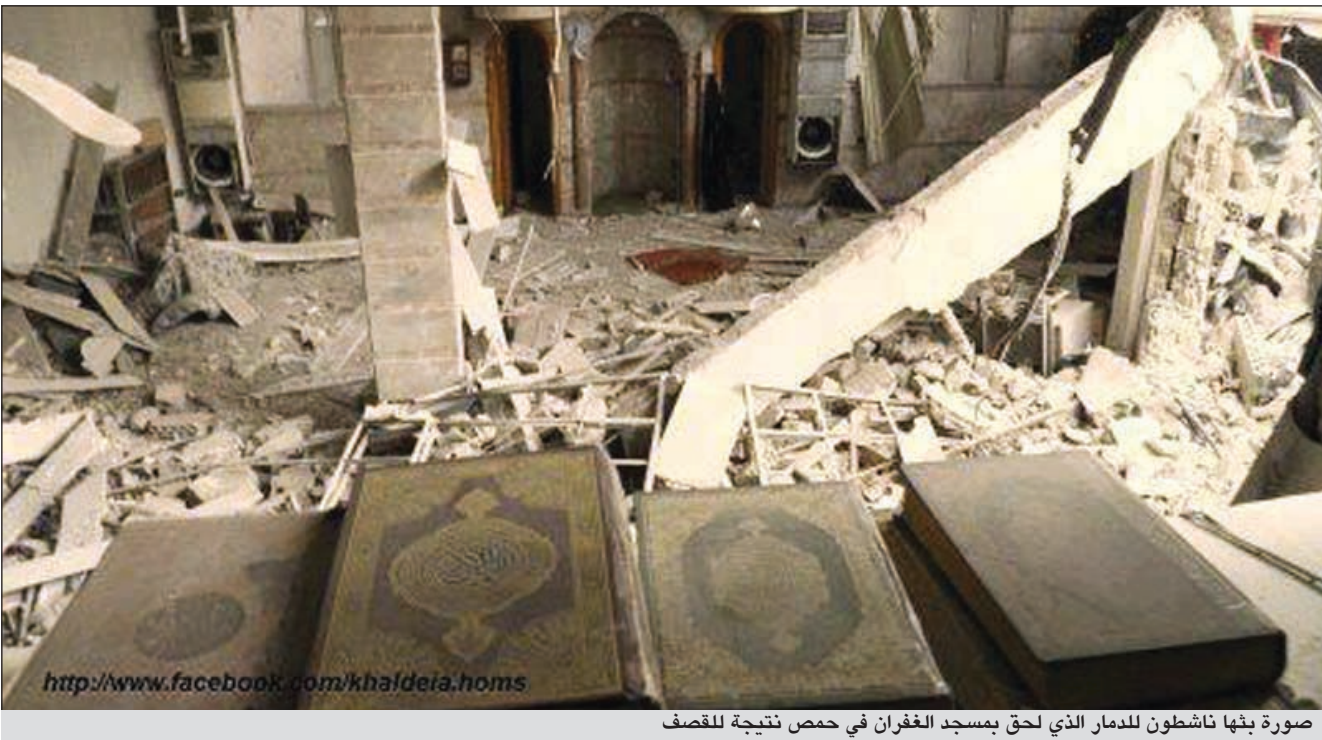
صورة بقها ناشطون للدمار الذي لحق بمسجد الغفران في حمص نتيجة للقصف
